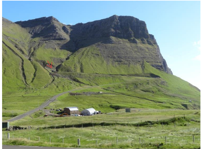
Blick zurück zum Pass mit dem Tunneleingang (↘)
